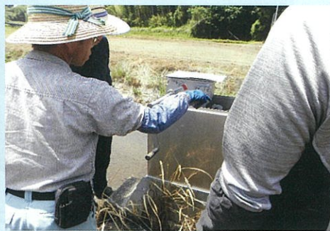
自動転倒ゲートの機能診断
