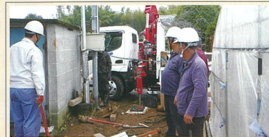
外園開田深井戸水中ポンプ入替工事
