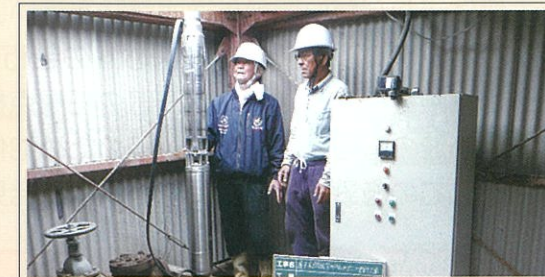
鹿子木開田深井戸水中ポンプ更新工事
