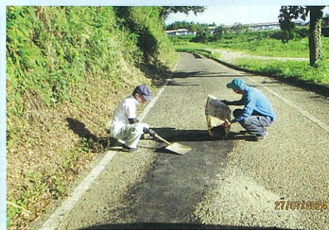
農道舗装の補修
