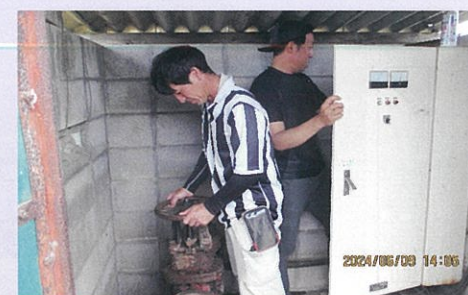
施設の点検 (パイプライン)
