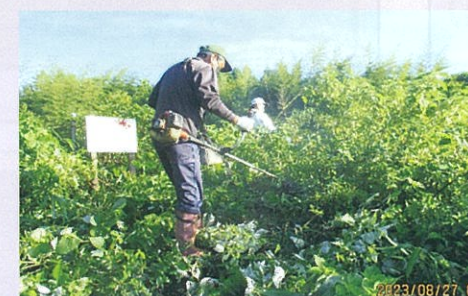
ため池の堤体の草刈り
