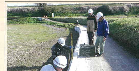
寄鶴農道舗装補修工事
