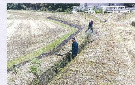
水路の泥上げ
