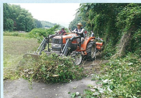
重機を使用しての農道の清掃
