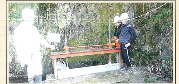
松ヶ迫取水ゲート改修工事
