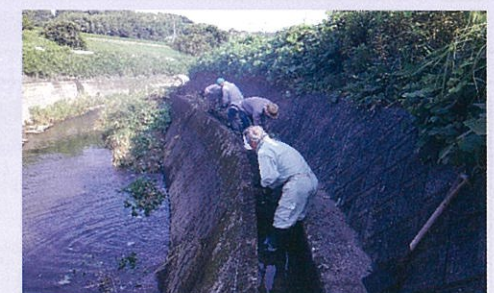
水路の泥上げ
