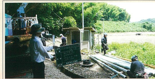
月形水利組合深井戸水中ポンプ更新工事
