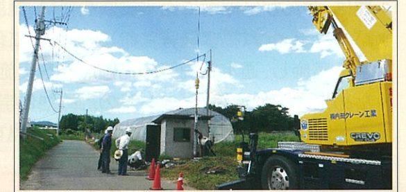
射の馬場開田組合深井戸水中ポンプ更新工事
