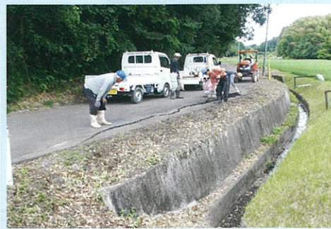
農道舗装の補修
