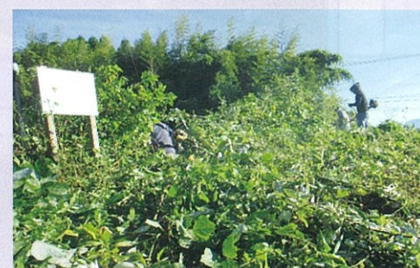
ため池の堤体の草刈り
