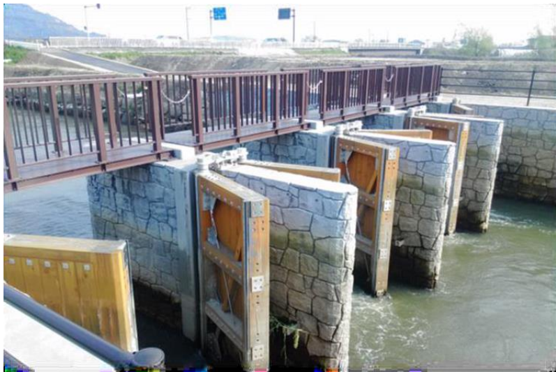
復旧した井樋堰
