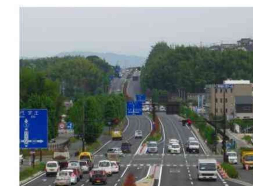
<⑪北バイパス-清水新地付近>
