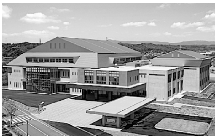
益城町総合体育館
