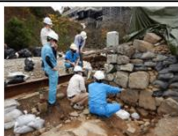
←写真：熊本城の復旧作業 (熊本城総合事務所)
