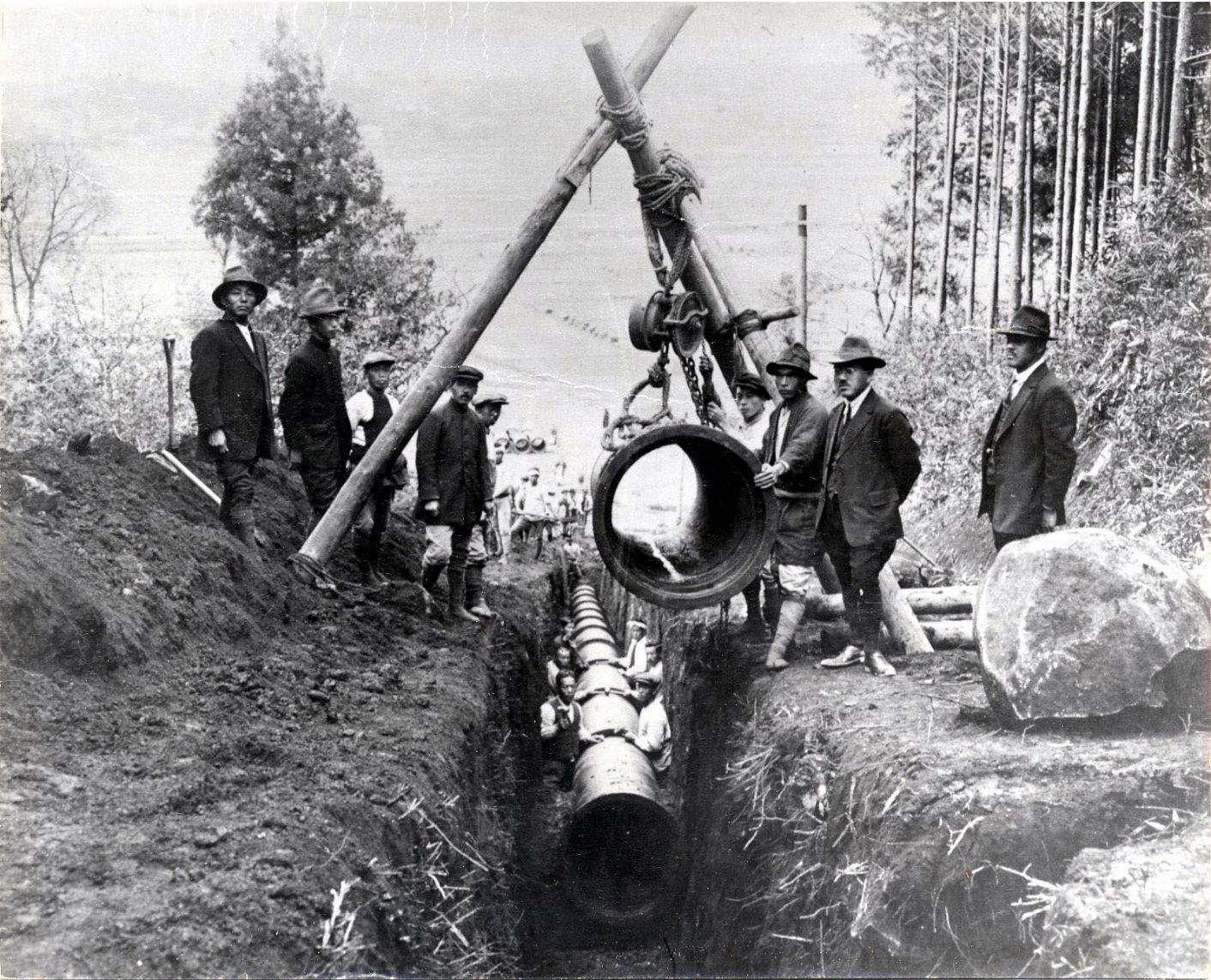
大正13年(1924年)頃 送水管布設工事
